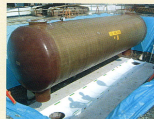
3. 製品設置(40m 3 長尺)
