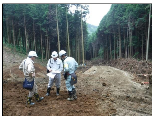
対策工事实施中箇所の点検状況
