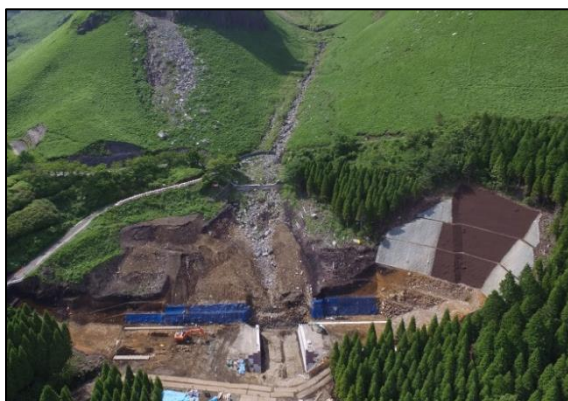
砂防堰堤の施工状況
