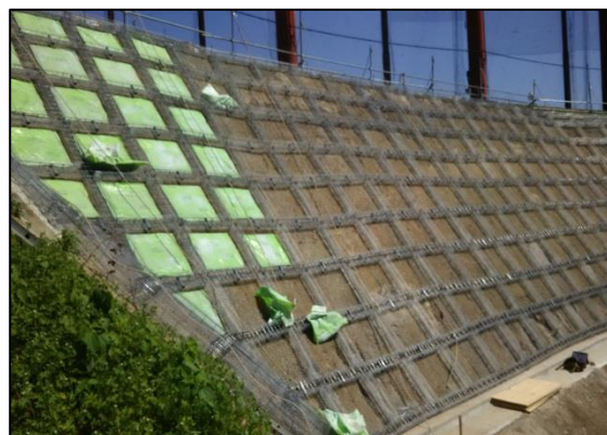
斜面崩壊防止施設の施工状況
