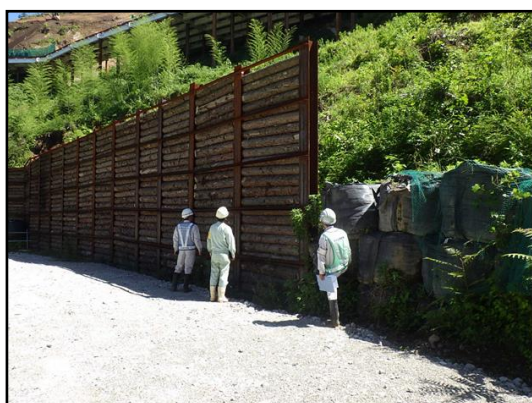
応急対策（仮設防護柵）を実施した箇所の点検状況
