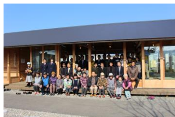
西原村小森第2のみんなの家 竣工/12月10日 設計/日本建築家協会九州支部 熊本地域会推薦グループ
