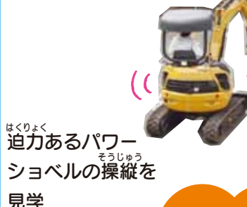
迫力あるパワーショベルの操縦を見学
