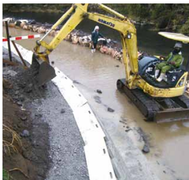
山都町の五老ヶ滝川、地震で崩れた川岸を直す工事を行っています
