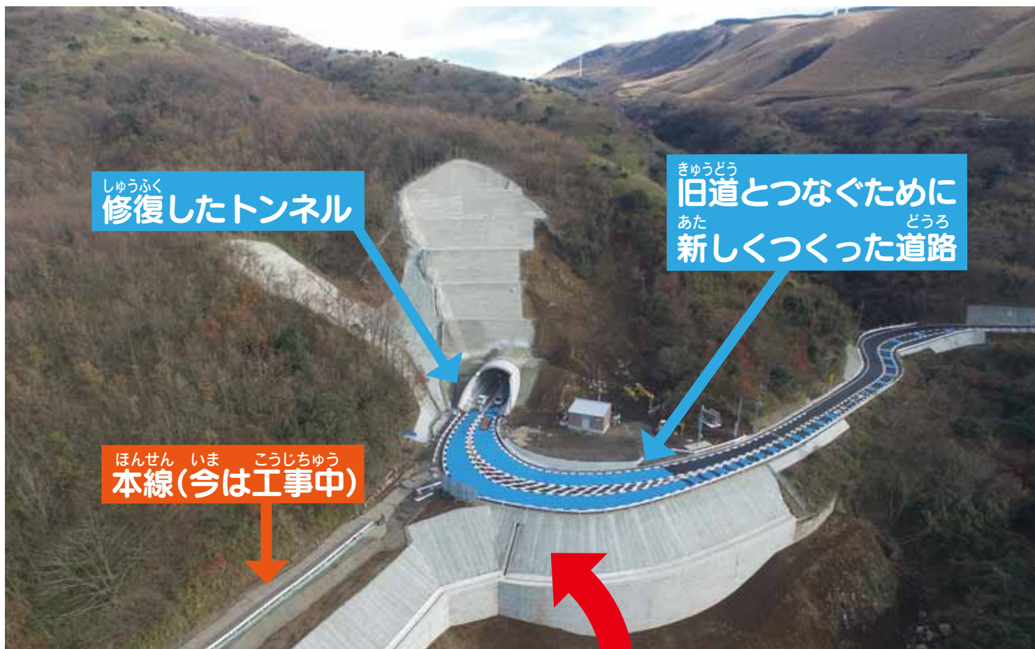
開通した俄山トンネル出入口(西原村側)
