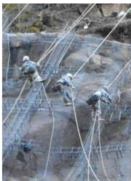
菊池阿蘇スカイラインの崩れた斜面を固める工事。命綱をつけ、大変な技術が必要です
