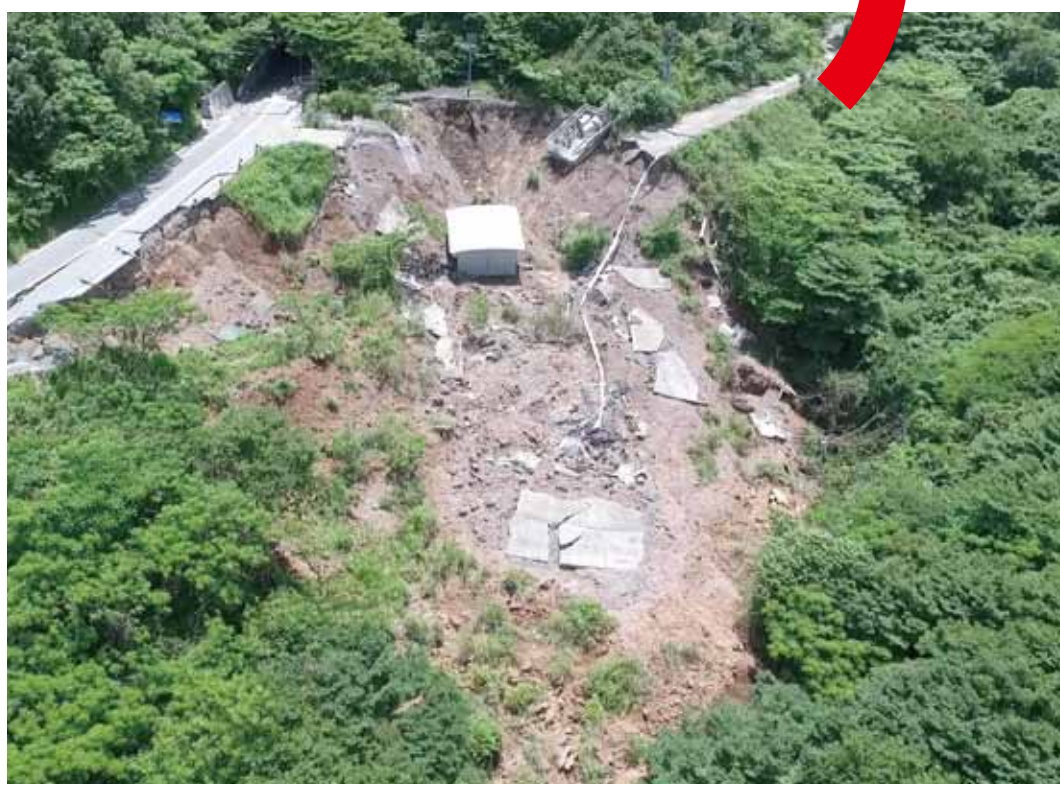
地震直後の俄山トンネル周辺
